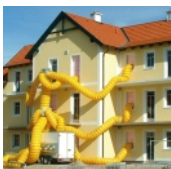
Bautrocknung
